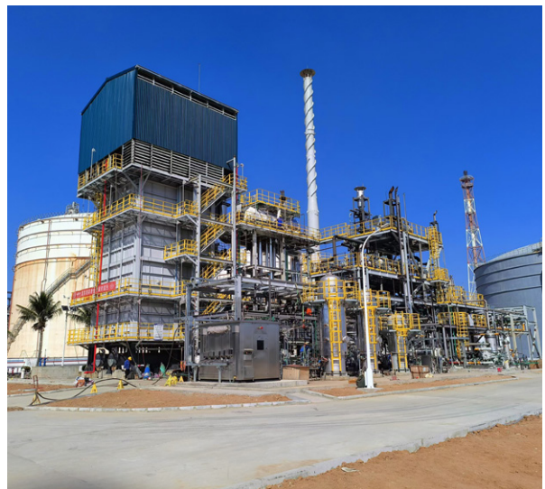
幹重整裝置完工
